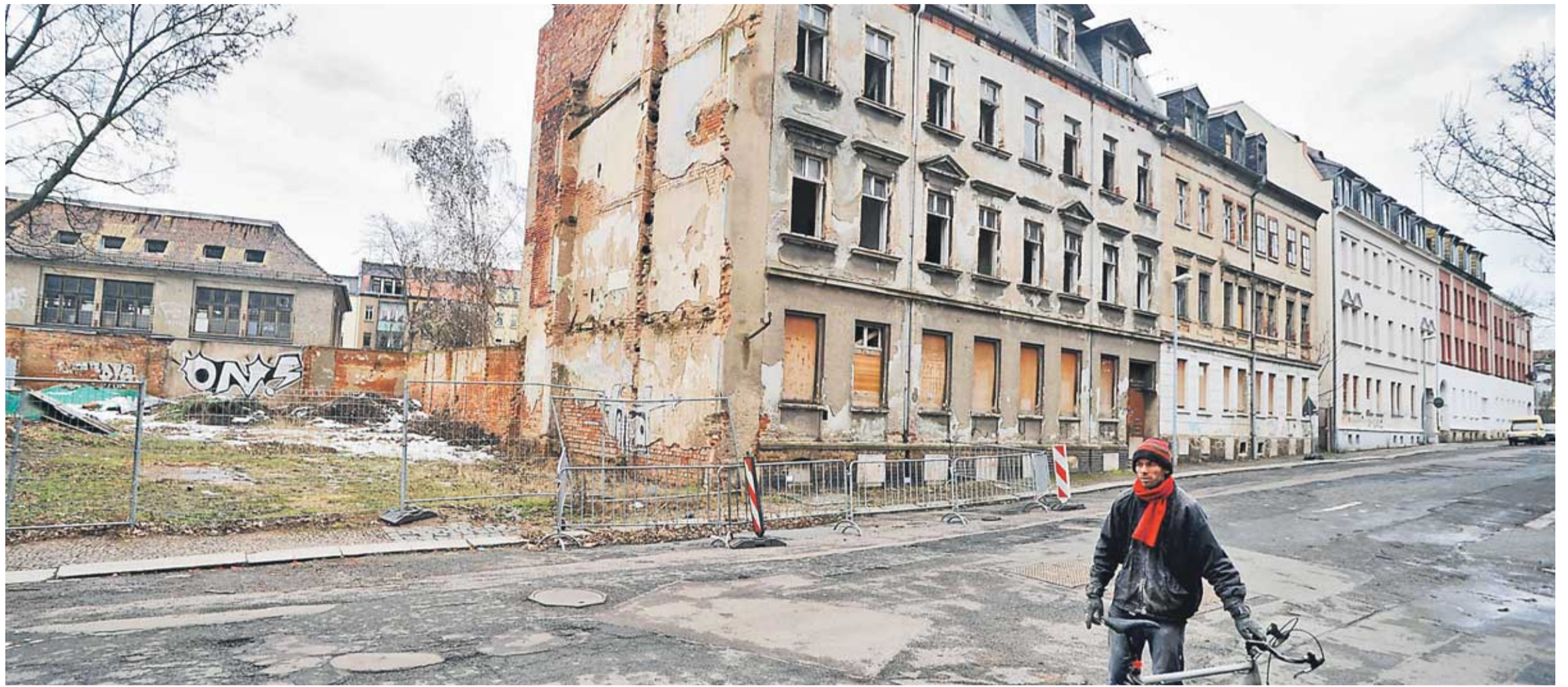
Kein schöner Land: Die Josephstraße in Lindenau. Menschen sieht man wenige vorübergehen. Doch der trostlose Anblick ist bald Geschichte: Das Haus im Hintergrund wird in den kommenden Wochen abgerissen, die Gebäude weiter rechts werden von eifrigen Privatleuten saniert. Die Entwicklung des Blocks an der Lützner Straße hat der Stadtteilverein Lindenau initiiert. Fotos: Armin Kühne (7), André Kempner (5).
